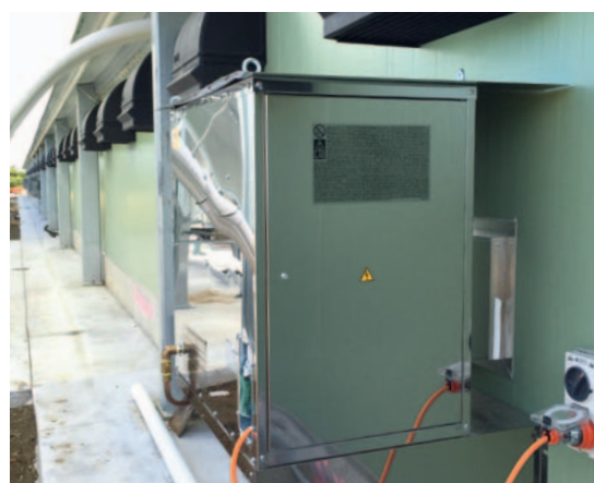
Montaż na zewnątrz
