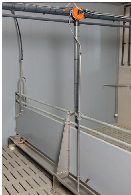
Czujnik rejestruje stan napełnienia koryta co do milimetra
