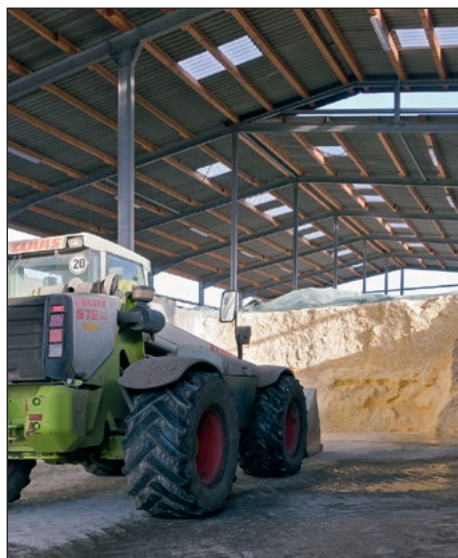
Zadany silos przejazdowy na CCM
