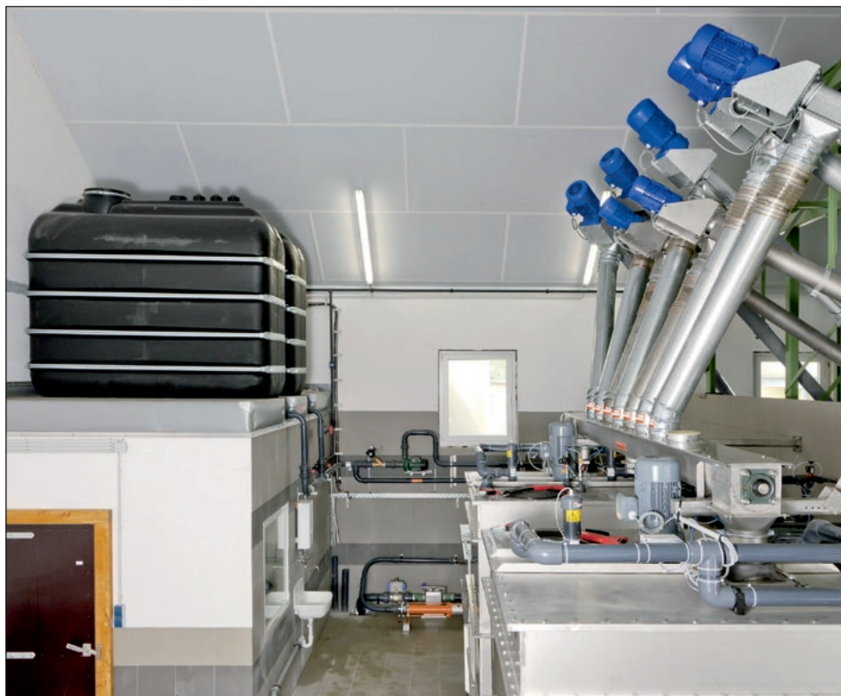
Kuchnia paszowa z 2 zbiornikami do żywienia bezresztkowego i dwoma 2000 l zbiornikami świeżej wody
