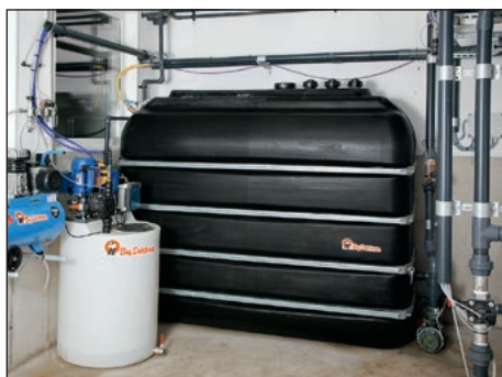
200 l zbiornik świeżej wody i stacjonarny system MediInject
