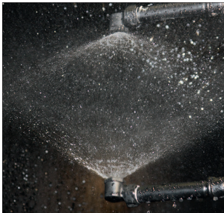
Specjalne umiejscowienie dysz – wyższy wskaźnik wiązania kurzu i NH 3
