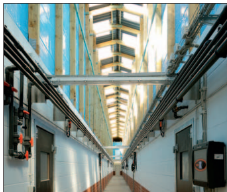
Po lewej i prawej stronie nad oddziałami znajdują się kanały zbierające zużyte powietrze
