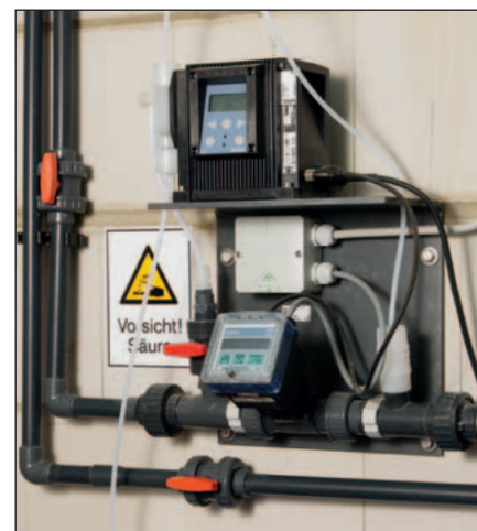
Dokładne dozowanie kwasu na podstawie mierzenia wartości pH
